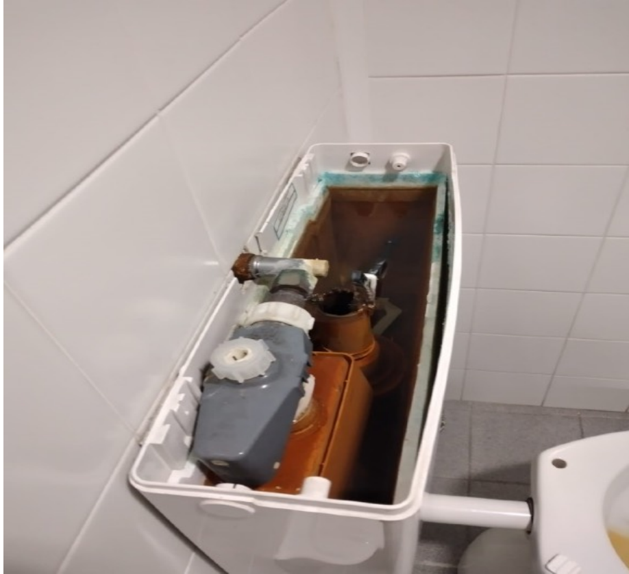
Foto ritraenti i servizi igienici del secondo piano del Palazzo di Giustizia, che denotano la scarsa manutenzione e il pessimo stato di conservazione, nonché anche del soffitto.
