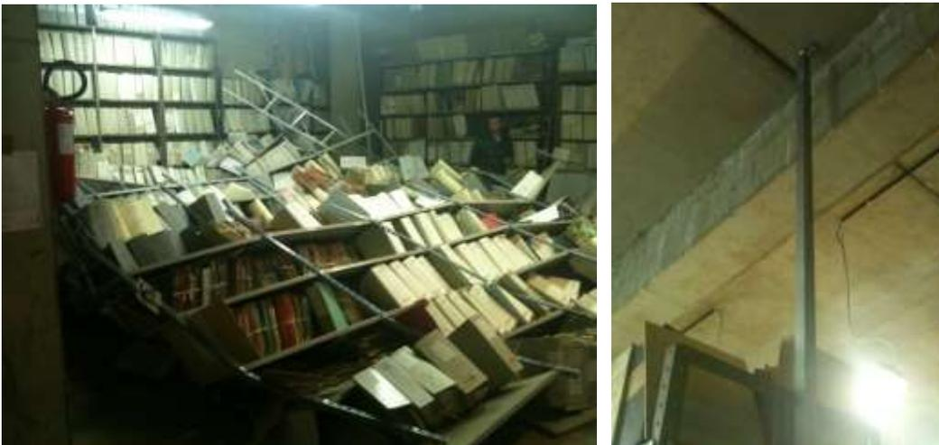
Il ripristino delle condizioni di sicurezza degli archivi fu effettuato con l'inserimento di sostegni metallici (visibili nelle foto) ancorati al soffitto che impedissero l'effetto domino.
