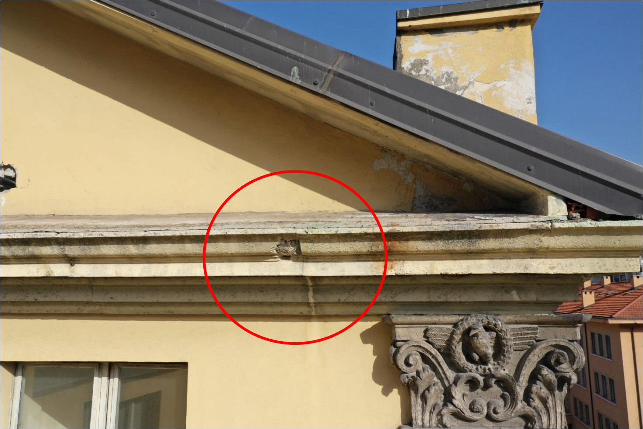
Altre lesioni sparse lungo le varie facciate del palazzo
