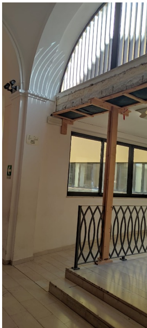
PALAZZO TORRES – Tribunale Penale – Primo Piano (particolare della trave sorretta da struttura di sostegno in legno).
