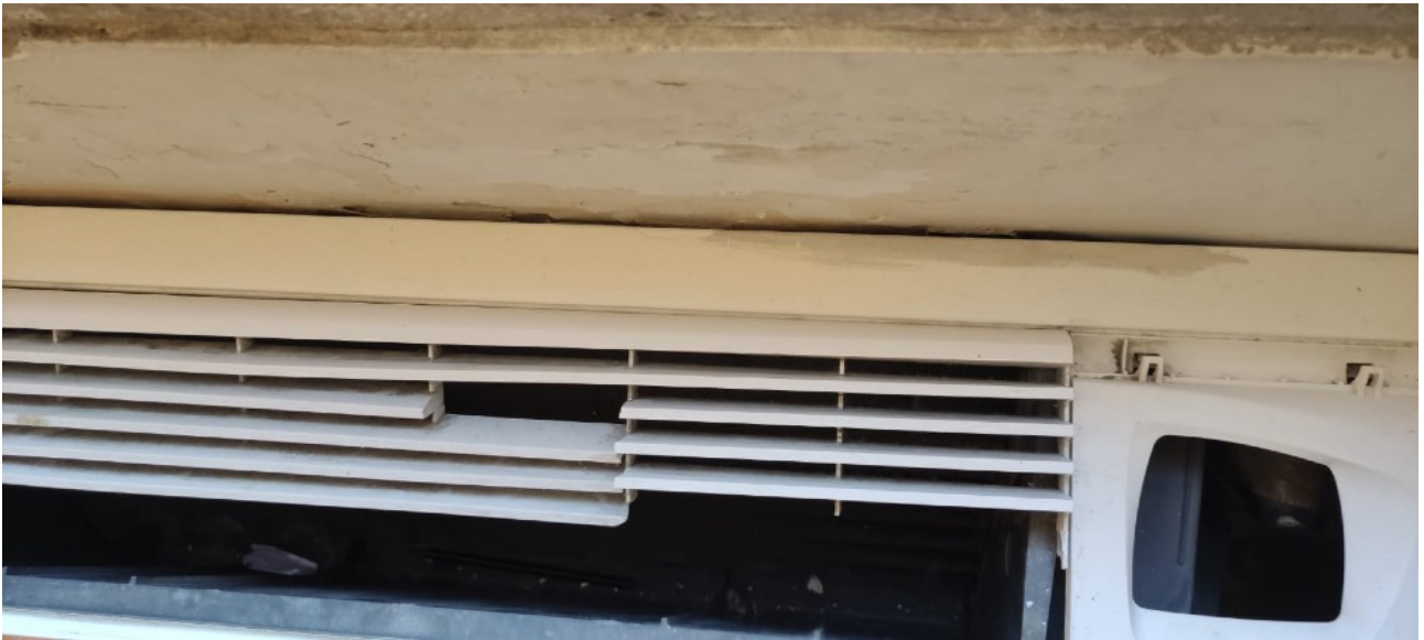
PALAZZO TORRES – PARTICOLARE IMPIANTO ARIA CONDIZIONATA
