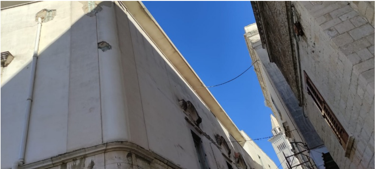
Impianto elettrico sospeso tra Palazzo Torres e Palazzo Candido
