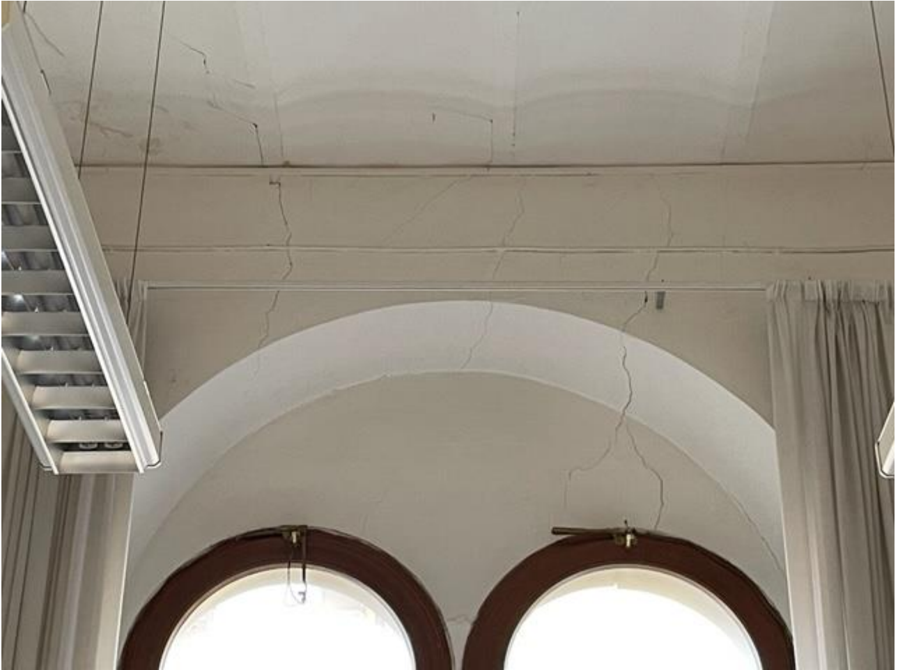
Parte del soffitto di un'altra stanza con evidenti crepe
