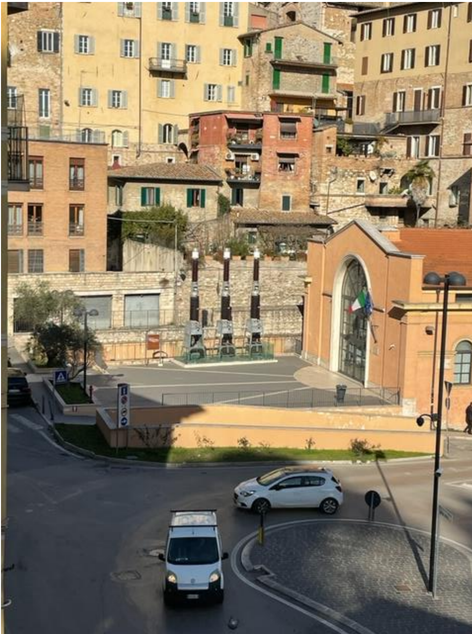
Esterno della facciata del Tribunale penale ripreso dal lato destro
